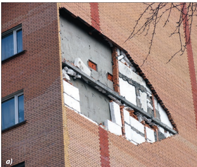
Аварийные ситуации: а — разрушение облицовочного слоя, б — конденсация влаги на поверхности облицовочного слоя
